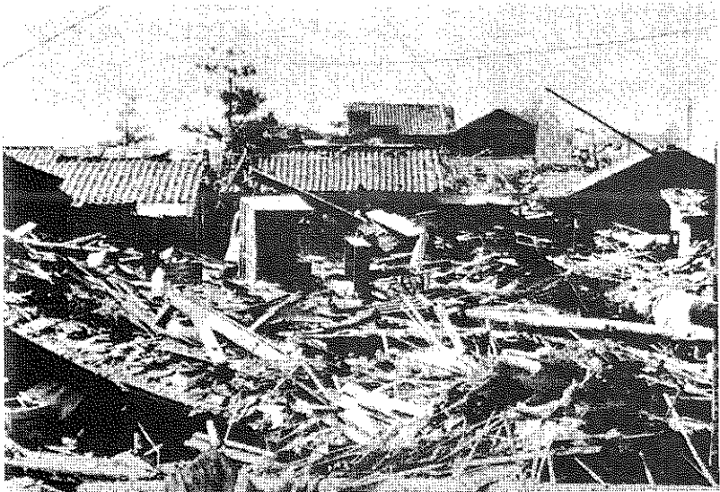
南千田町付近 南千田町一帯の民家の倒壊（菊池俊吉氏撮影）
