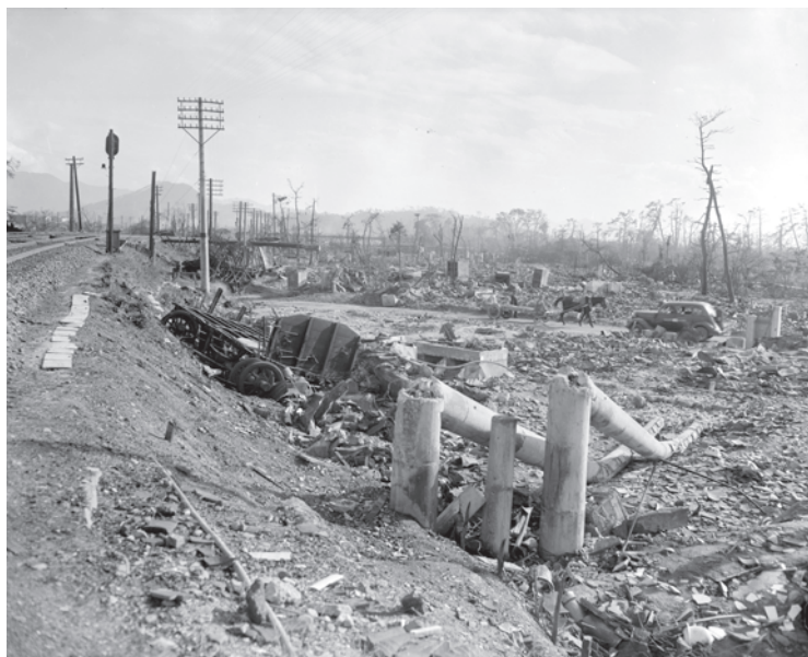
山陽本線、神田川鉄橋東側の線路敷より南東を望む
